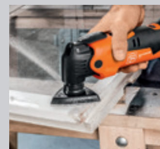
Complete kozijnrenovatie – overal, ook zonder netstroom.
