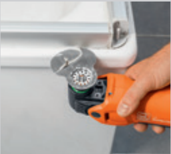
Elastische afdichtmaterialen kunnen vóór het opnieuw voegen perfect worden verwijderd.
