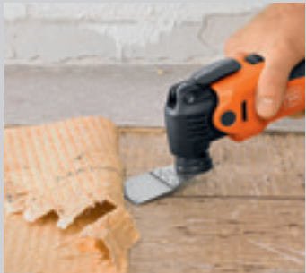
Met het starre plamuurmes kunnen tapijt- of lijmresten snel, eenvoudig en volledig worden verwijderd.
